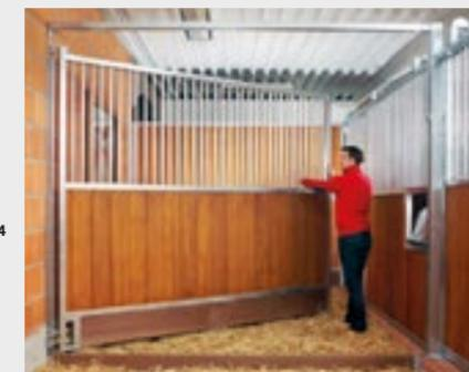
S'il est prévu d'enlever le fumier de box individuels avec un tracteur de cour, la paroi avant pivotante est une solution idéale.
