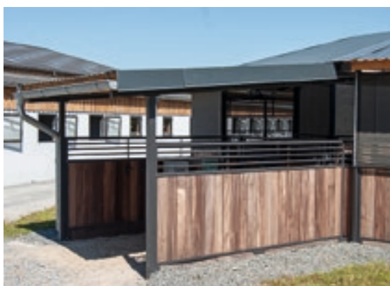
Toit en appentis
